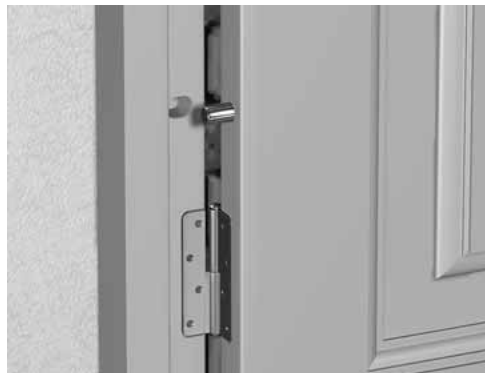
Рис. 2.4. Усиление соединения дверного полотна с коробкой
