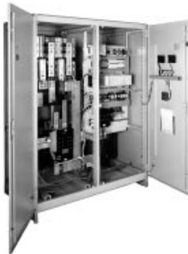
Рис. 3.21. Тиристорный выпрямитель фирмы Benning
